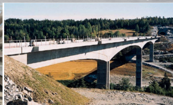
Holendalen Eisenbahnbrücke / Norwegen
